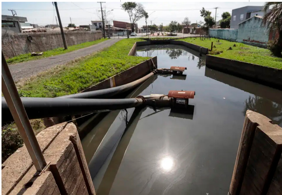
▲ Buscando enfrentar os eventos climáticos extremos, o poder público adota soluções emergenciais e programas de desassoreamento, além de piscinões e canalizações para controle de enchentes
